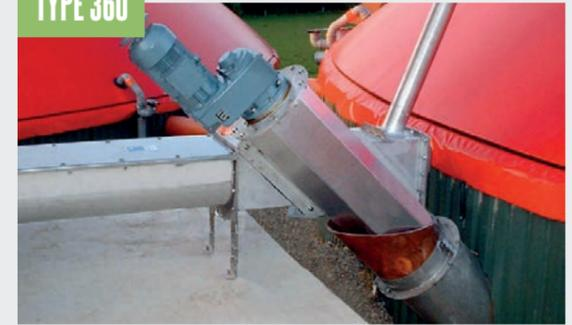
VIS SANS FIN INFÉRIEURE ET DU DIGESTEUR
